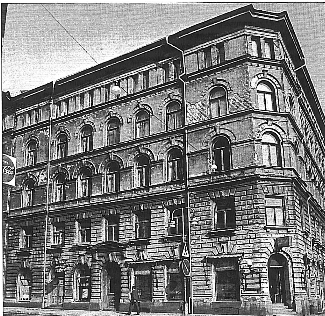
En del av Brf Lyran 15:s fastigheter som de såg ut innan renoveringen påbörjats.
