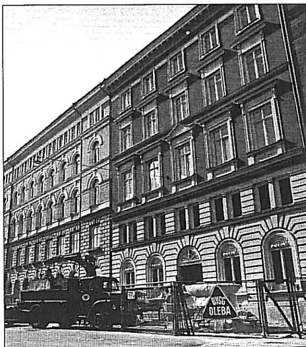
Husen Styrmansgatan 47 och 49 just inför slutspurtan av Bygg- Olebas renovering 1972.
